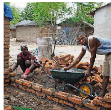
Den Bau des zweiten Schulhauses werden Arbeiter aus Chembe ausführen.
